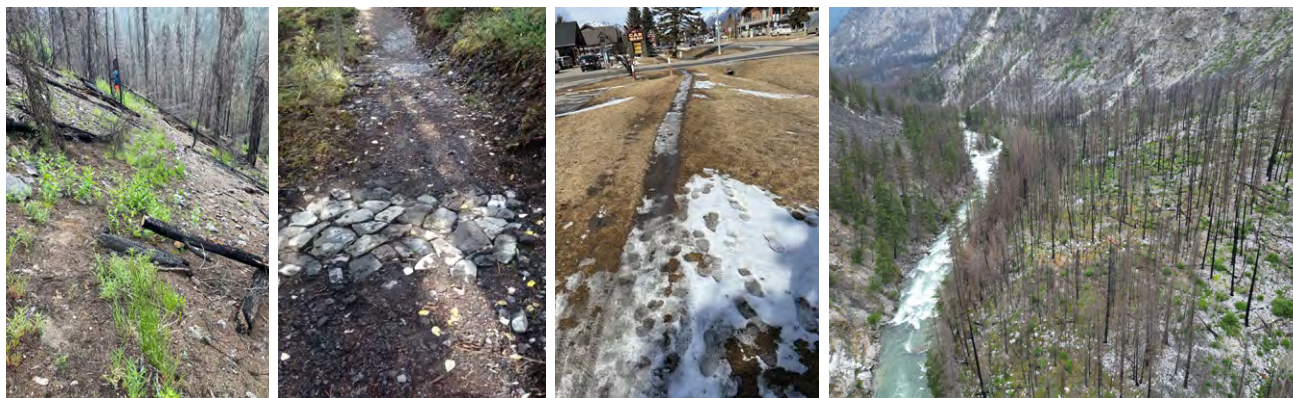
Figure 1. Érosion, enrochement, environnements sujets au gel-dégel, zone brûlée (de gauche à droite)
